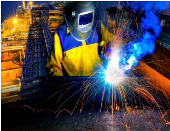
✓ Soldadura en general.
